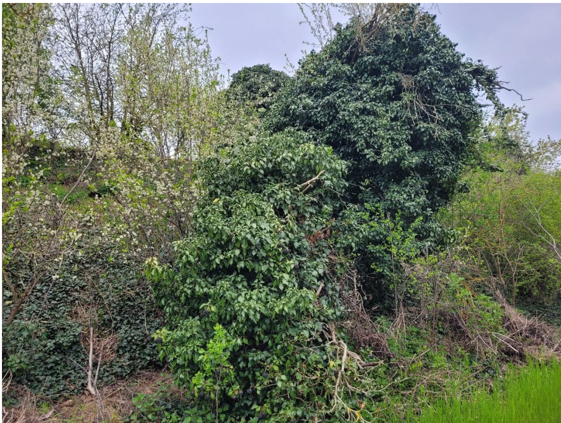
Abbildung 12 Bereiche mit starkem Überwuchs von Efeu
