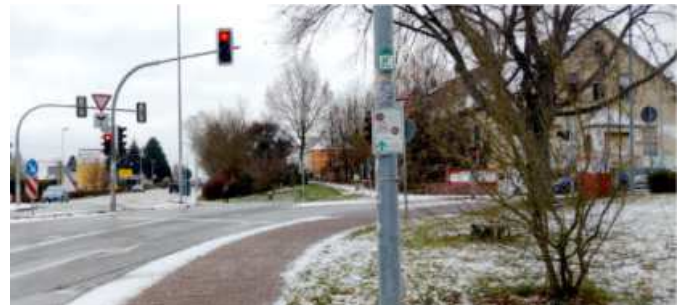
Abb. 6 Anbringung von Zwischenwegweisern (ZWW) in Kombination mit zugelassenen Verkehrszeichen und an Lichtmasten
