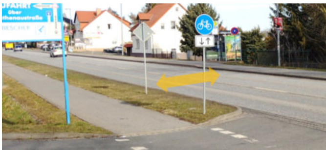
Abb. 161 Querungsbedarf Hallesche Straße Höhe Am Kalten Graben für den Radverkehr, aber auch zur generellen Erreichbarkeit der Bushaltestelle
