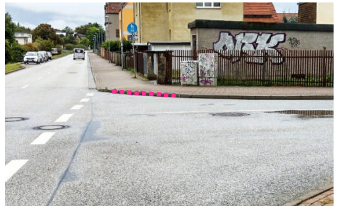
Abb. 159 Karl-Fischer-Straße / Steinkopfstraße: Bordabsenkung
