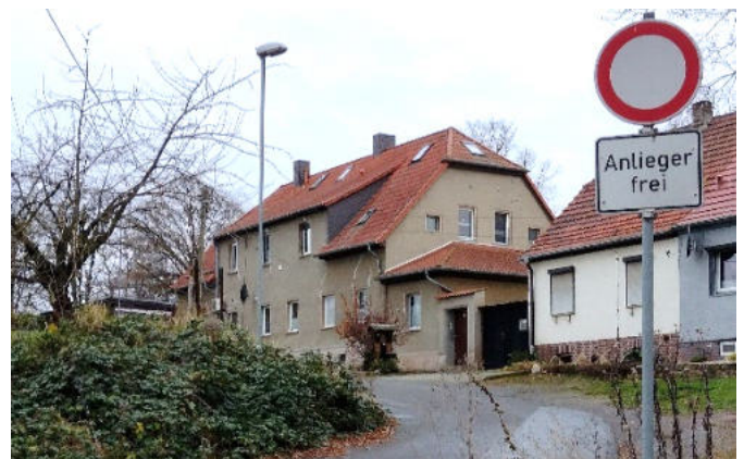
Abb. 119 Oberhütte (Radweg Saale-Harz Bestand)
