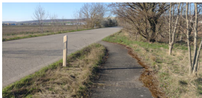
Abb. 98 Ende des Radweges an der Alten Hauptstraße
