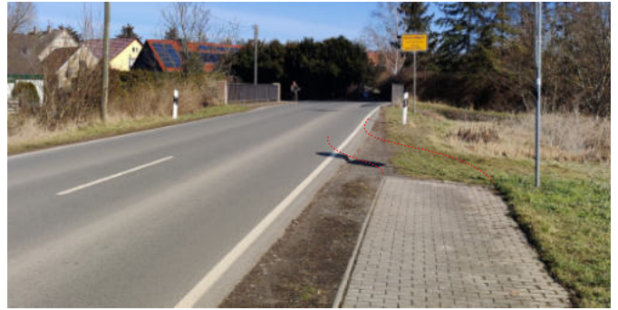
Abb. 65 Ende des Weges in der Unterrißdorfer Straße
