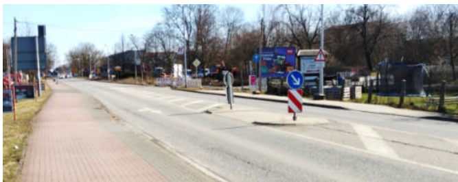
Abb. 158 Vorbild für richtlinienkonforme Mittelinsel als gängige Form einer Querungsanlage: Hallesche Straße
