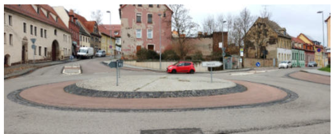
Abb. 52 Kreisverkehr Nußbreite / Hohetorstraße
