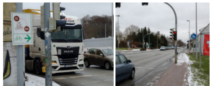
Abb. 80 ZWW an der Halleschen Straße, Wegweisung ist im Stadtzentrum lückenhaft
