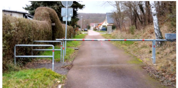
Abb. 66 Hindernisse in der Bergstraße in Volkstedt
