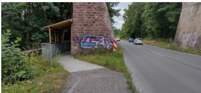
Abb. 93 Schmale Führung des Radwegs unter der Millionenbrücke
