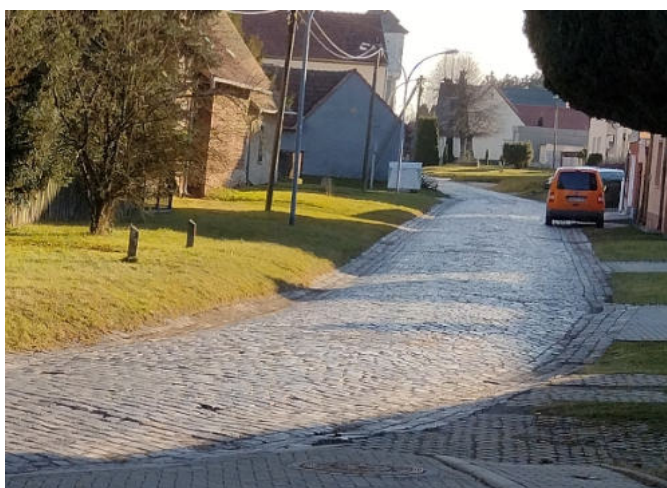
Abb. 103 Bischofrode Straße der Einheit mit Sanierungsbedarf
