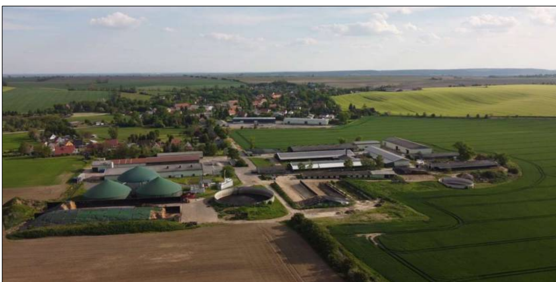
Abb. 2 - Blick von Norden Richtung Süden auf Teile des Änderungsgebietes
