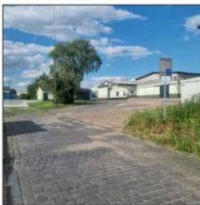
25 - Blick Richtung Norden auf das Gelände der Agrargenossenschaft und die Biogasanlage.
