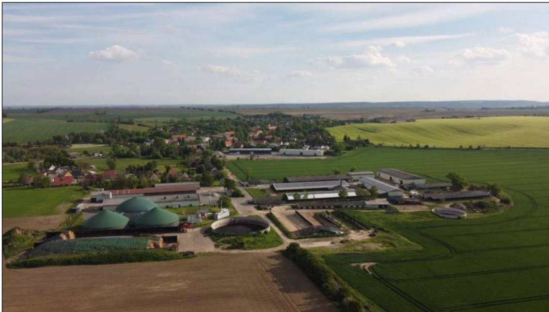
Abb. 3 – Blick von Norden Richtung Süden auf Teile des Plangebietes
