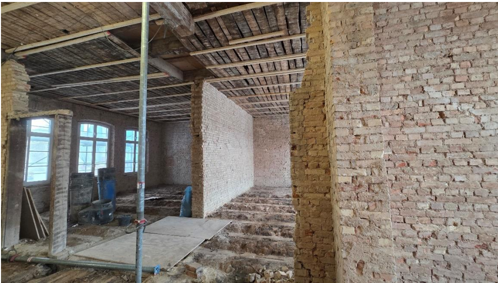
Abbruch der Wände im östlichen Treppenhaus
