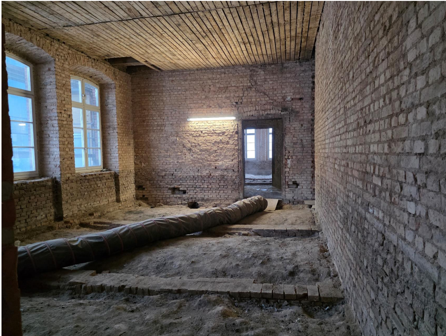
Gewölbedecke mit Bauheizung
