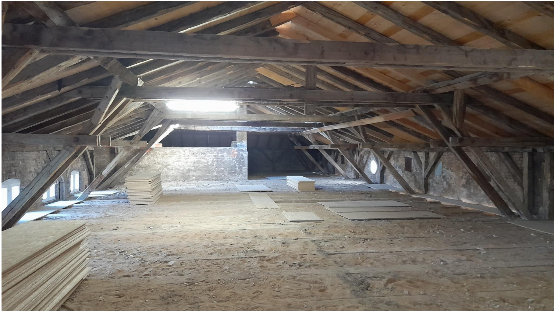
Blick in das entkernte DG
