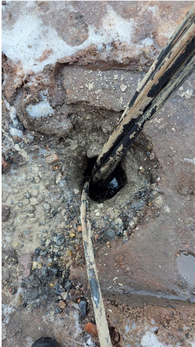
Fertiggestellte Erdsonde der Geothermie
