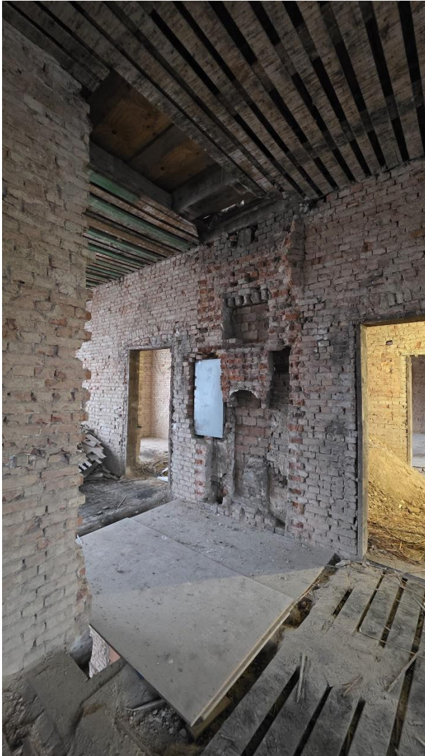
Blick auf die nicht homogene Innenwand (gestörtes MW-Gefüge)
